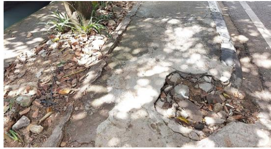
Gambar 10. Kerusakan Material Jalur Pedestrian Jalan Jenderal Urip Sumoharjo Kota Pontianak
