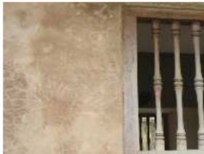
Gambar 19. Dinding dengan Bligon
