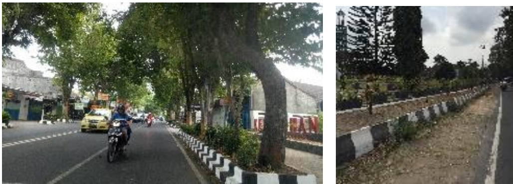
Gambar 3. Kondisi Eksisting Jalur Pejalan Kaki (Dokumentasi Tim RTH Magister Ilmu Lingkungan, 2017)
