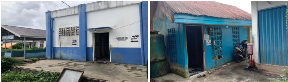
Gambar 13. Fasilitas Toilet Pasar Tradisional Modern Barabai Sumber: Penulis, 2022
