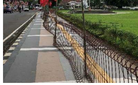
Gambar 3 Kondisi Ruang trotoar di depan Rita Supermall Jalan Jenderal Sudirman Sumber: Dokumentasi Pribadi, 2021
