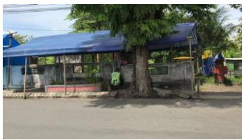
Gambar 4 Kondisi Ruang trotoar seberang Lapangan Glempang Jalan Prof. Dr. HR Bunyamin Sumber: Dokumentasi Pribadi, 2021
