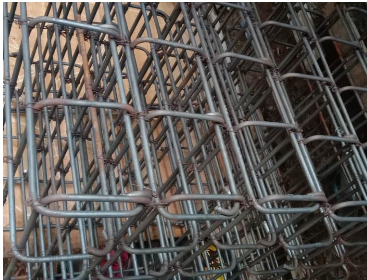
Gambar 1.3 rakitan tulangan balok yang akan digunakan dalam penelitian.
