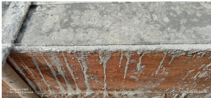
Gambar 1.4 balok tulangan yang telah dicor
