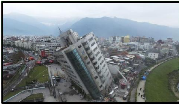
Gambar 11 kerusakan gedung akibat gempa
