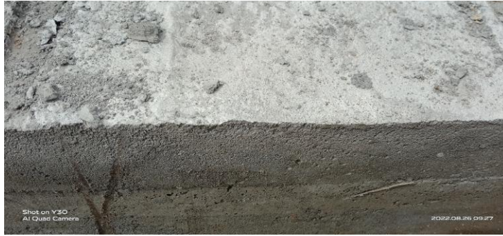
Gambar 1.6 balok tulangan yang telah dibuka bekistingnya
