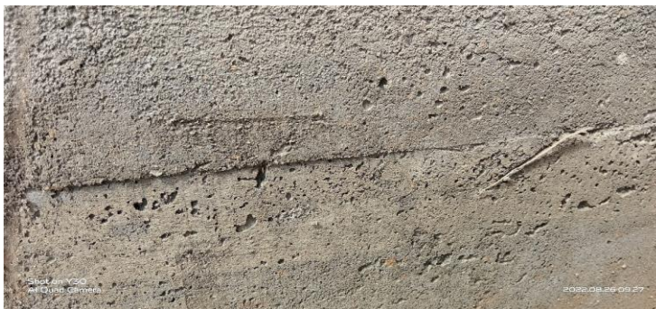
Gambar 1.7 balok dengan serpihan besi yang telah dibuka bekistingnya
