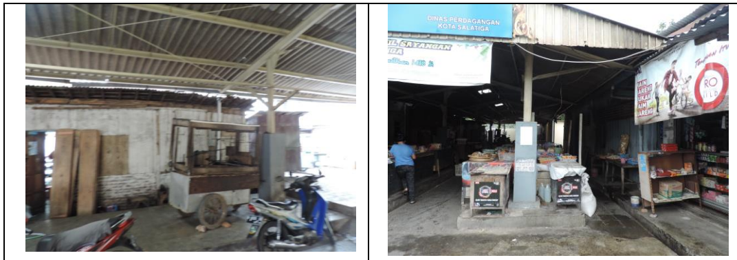
Gambar 4. Kondisi Eksisting Kios Pasar Sayangan
