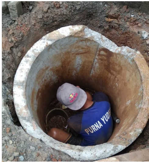
Gambar 3. Perkuatan Dinding Sumur Resapan Menggunakan Buis Beton
