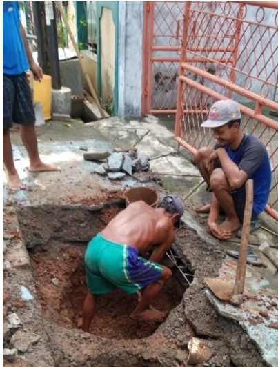
Gambar 2. Proses Pembuatan Galian Sumur Resapan
