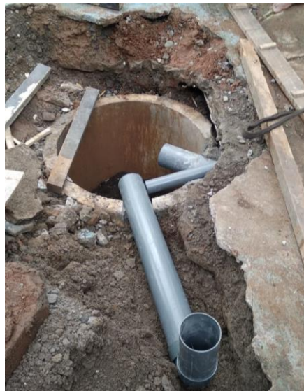
Gambar 4. Proses Pembuatan Saluran Water Inlet
