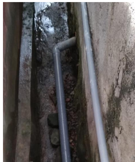
Gambar 5. Proses Pembuatan Saluran Water Outlet
