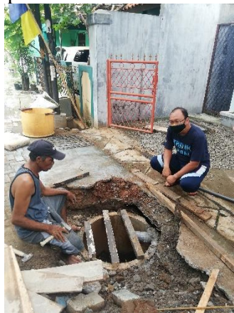
Gambar 10. Proses Pengawasan Pembuatan Sumur Resapan
