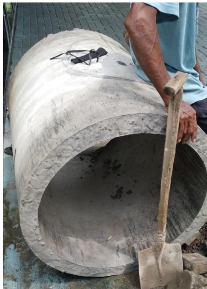
Gambar 1. Persiapan Bahan Pembuatan Sumur Resapan
