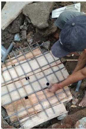
Gambar 8. Proses Penutupan Sumur Resapan
