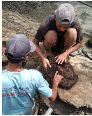
Gambar 7. Proses Pengisian Ijuk kedalam Sumur Resapan
