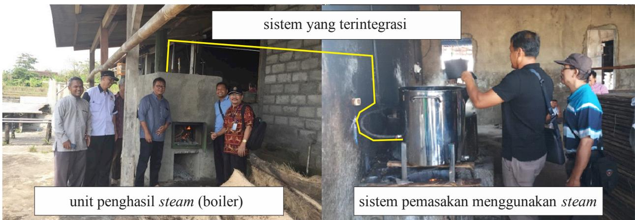
Gambar 5. Implementasi nyata integrasi unit penghasil *steam* dan sistem pemasakan pada UKM
