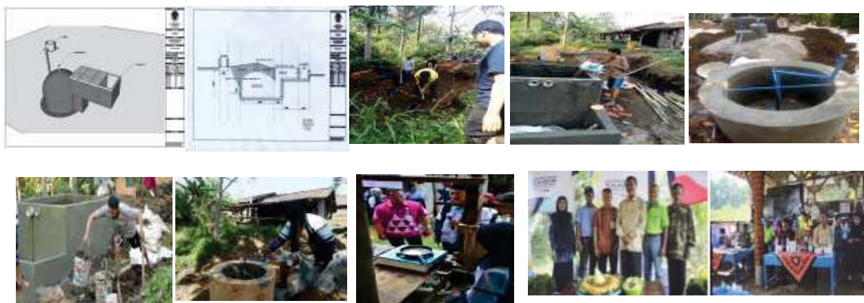
Gambar 1. Foto kegiatan gambar desain, pembangunan instalasi biogas, pengisian digester, uji coba kompor biogas dan peresmian instalasi biogas
