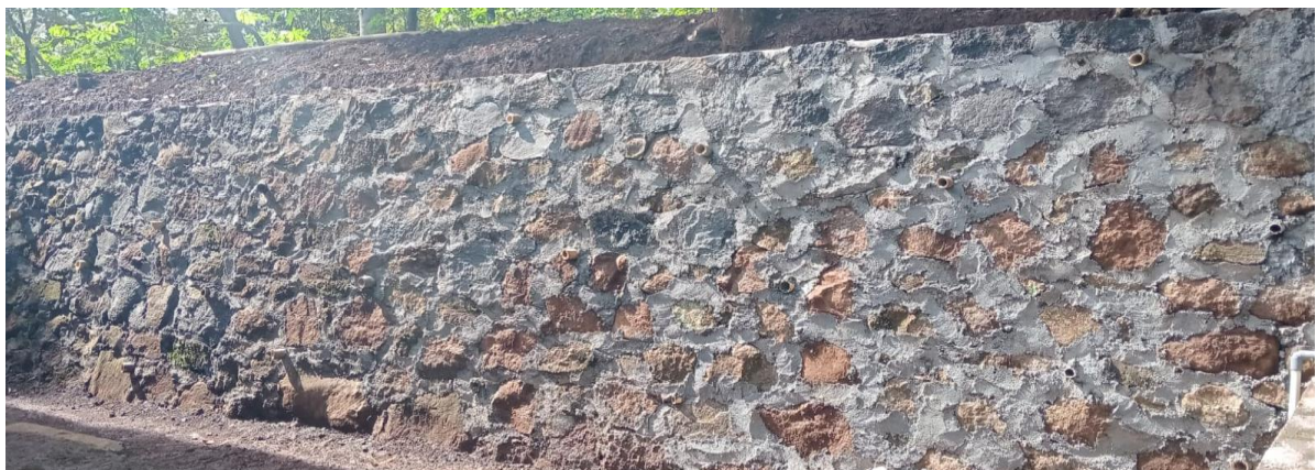
Gambar 4. Konstruksi Dinding Penahan Tanah
