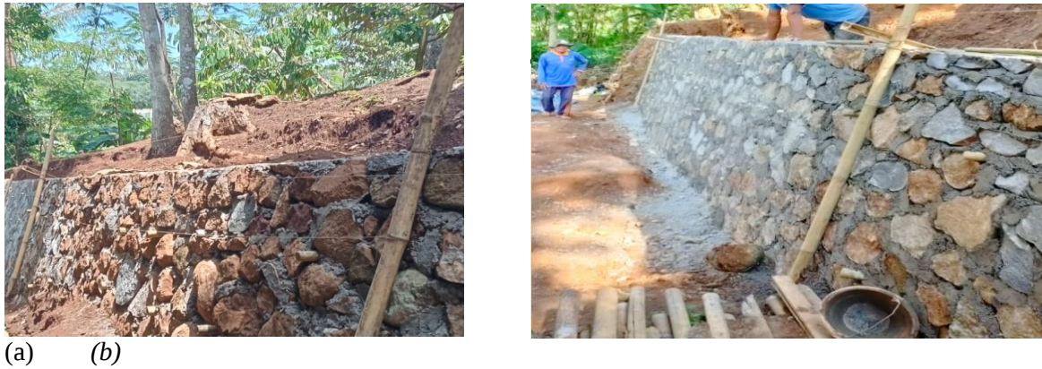
Gambar 3. Pembangunan Dinding Penahan Tanah
