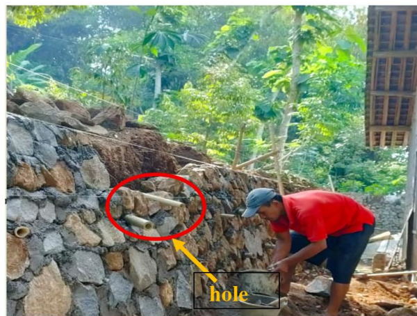
Gambar 2. Pemasangan Weep Holes
