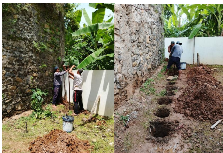
Gambar 4. Pengeboran tiang pondasi perkuatan DPT
