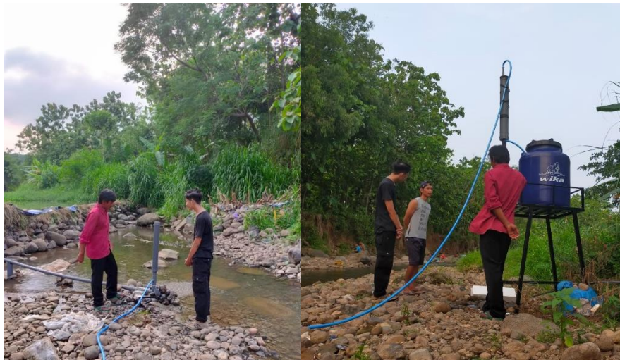
Gambar 12. Pemasangan pompa hidram (kiri) dan filter air sungai yang airnya akan dialirkan ke torrent (kanan) pada titik lokasi pilihan di Sungai Jabungan.
