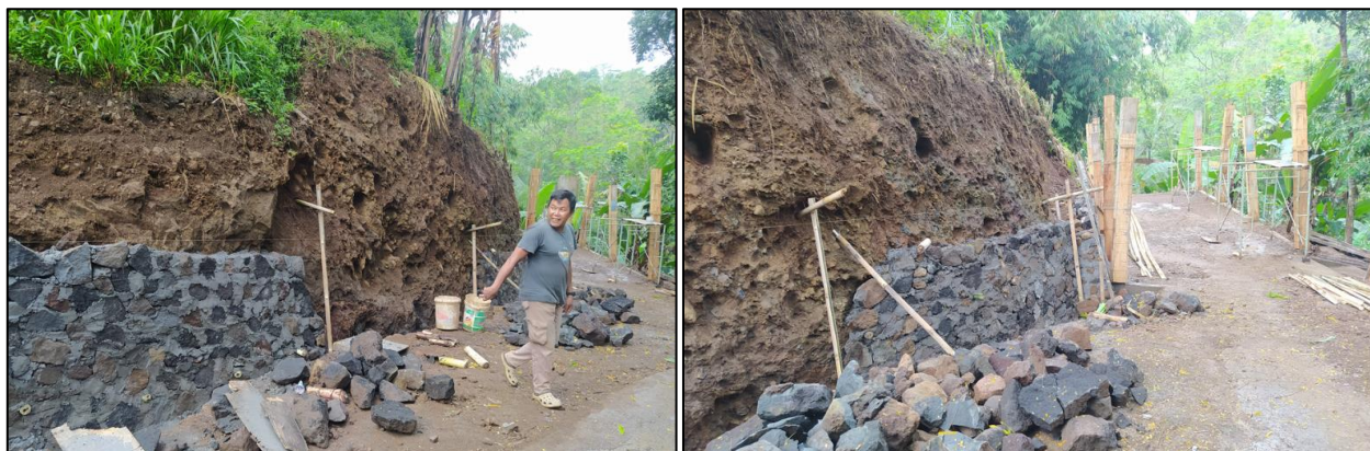
Gambar 3. Pemasangan Batu Kali pada Dinding Penahan Tanah
