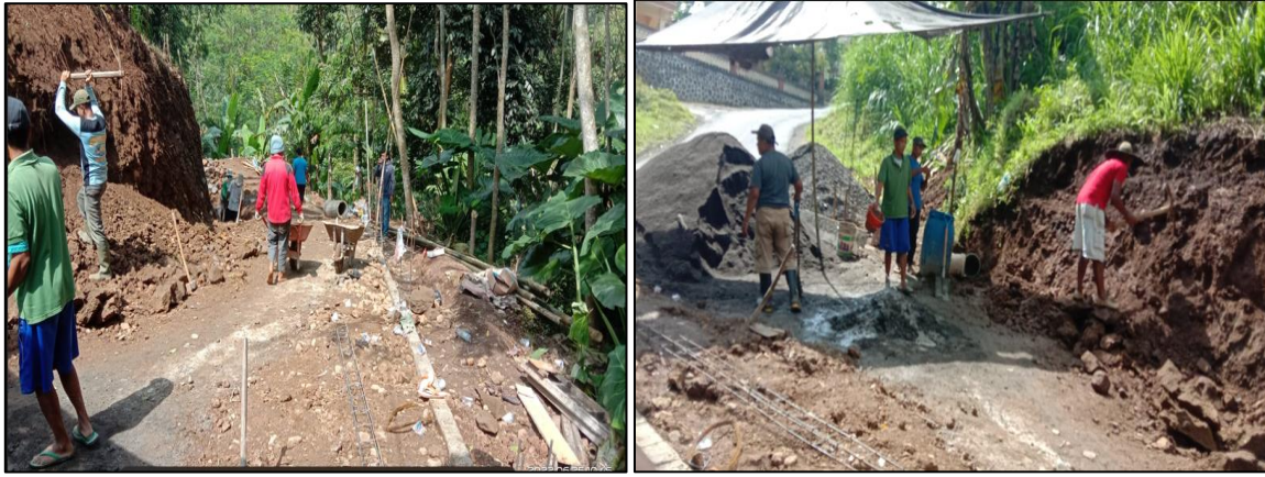
Gambar 4. Proses Perataan Jalan oleh Warga Dusun Setro Desa Jembrak Kecamatan Pabelan Kabupaten Semarang
