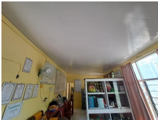
Gambar 7. Hasil pengecatan dinding ruang kantor MI Pancakarya
