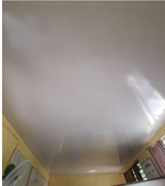
Gambar 5. Hasil pemasangan plafon
