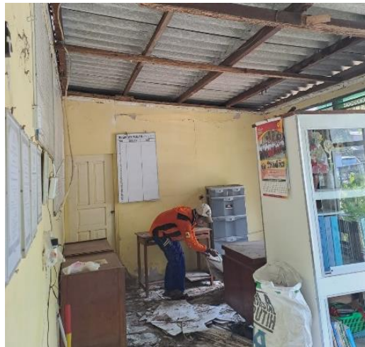
Gambar 3. Pembongkaran plafon lama
