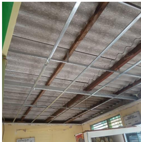
Gambar 4. Pemasangan rangka baja ringan
