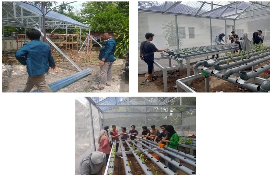
Gambar 9. Praktek Pembuatan Green House dan Instalasi Hidroponik
