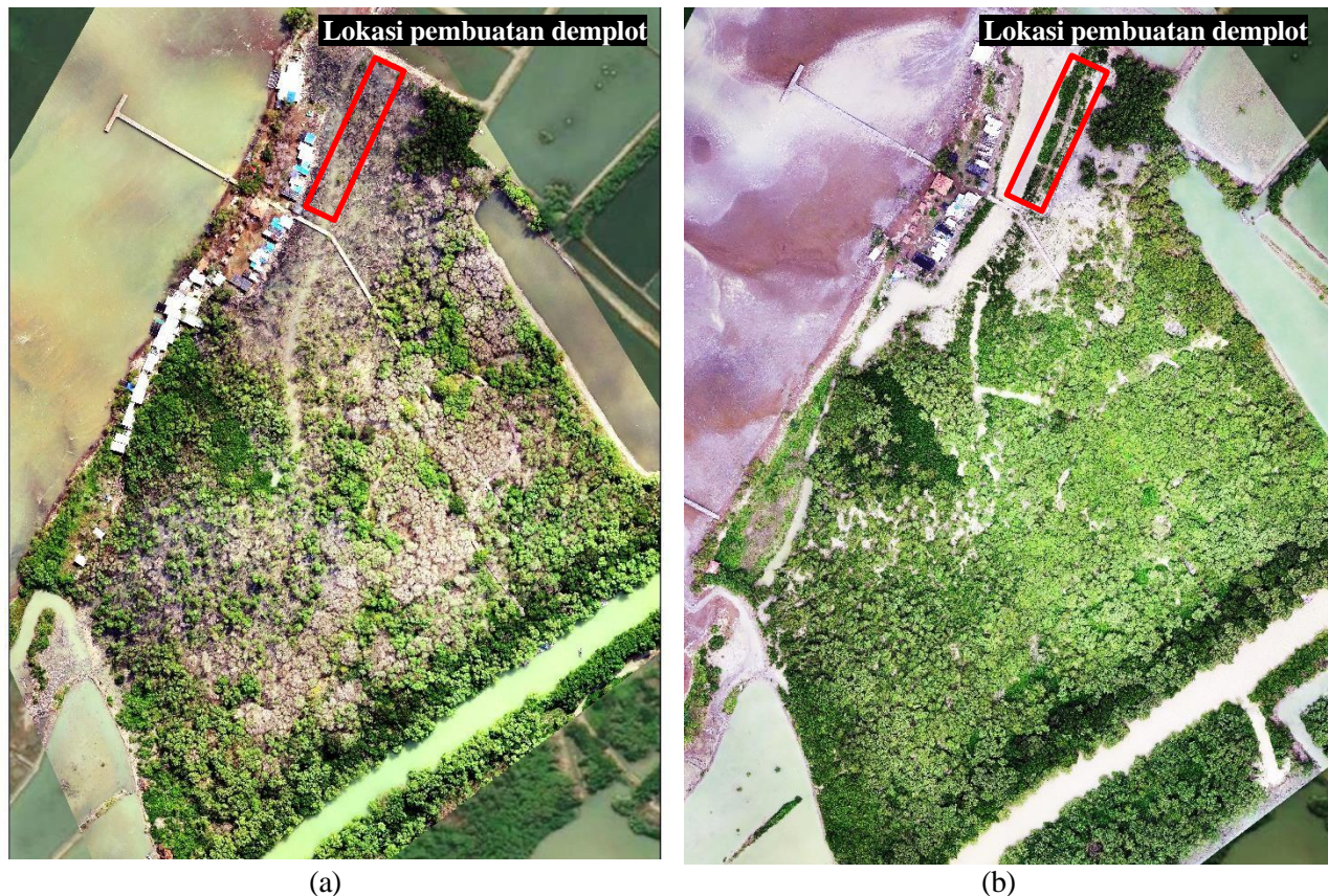
Gambar 3. (a) Kondisi Awal Pesisir Desa Tambakbulusan Juni 2021, (b) Kondisi Pesisir Desa Tambakbulusan Setelah dilakukan Rehabilitasi dan Perbaikan Hidrologi Desember 2022
