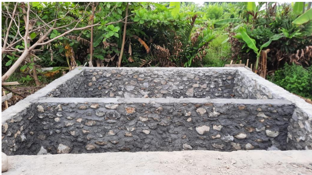
Gambar 7. Pondasi Batu Kali yang Telah Selesai Dibuat
