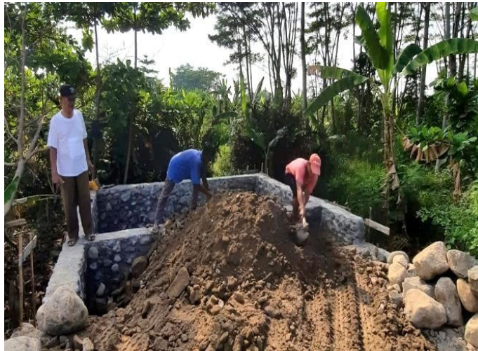
Gambar 8. Pengurukan Tanah pada Pondasi yang Telah Selesai Dibuat
