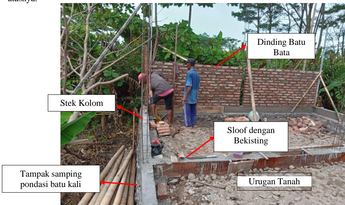
Gambar 9. Pembuatan Slof dan Pemasangan Stek Kolom di Atas Pondasi
