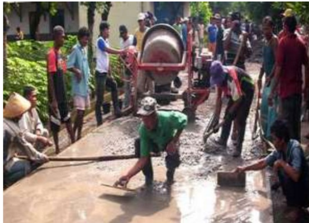
Gambar 6. Pelaksanaan Pengerjaan Jalan Rabat Beton
