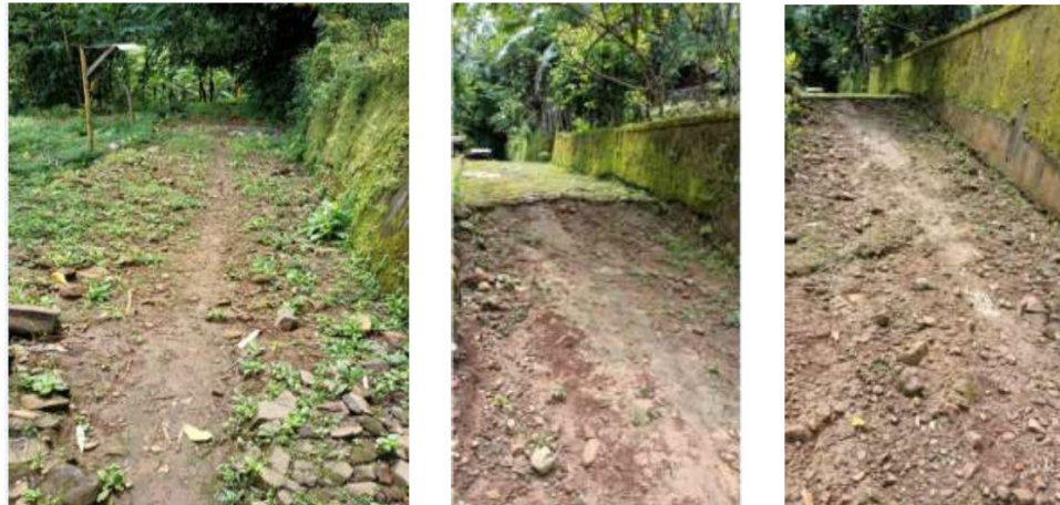
Gambar 1. Kondisi Existing Jalan Penghubung Desa Jembrak
