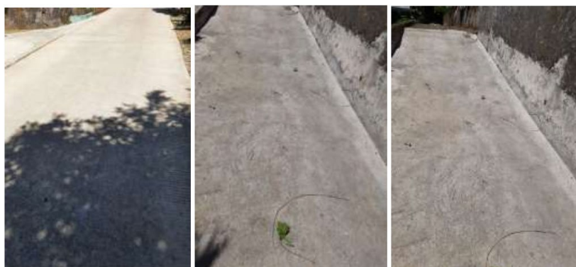
Gambar 7. Kondisi Jalan yang Telah Selesai
