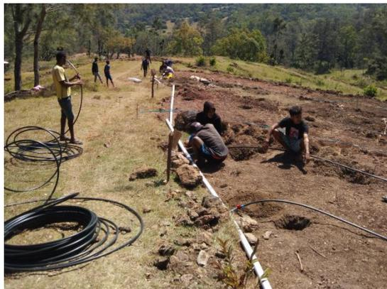
Gambar 7. Pemasangan Pipa HDPE Berdiameter 2 inch
