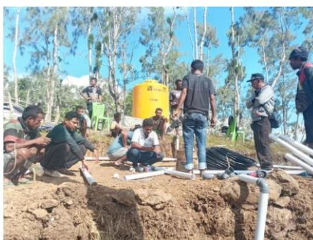
Gambar 3. Proses Instalasi Pipa Utama Jaringan Irigasi Tetes
