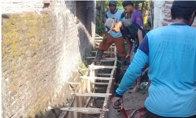
Gambar 6. Proses galian dan pemasangan bekisting
