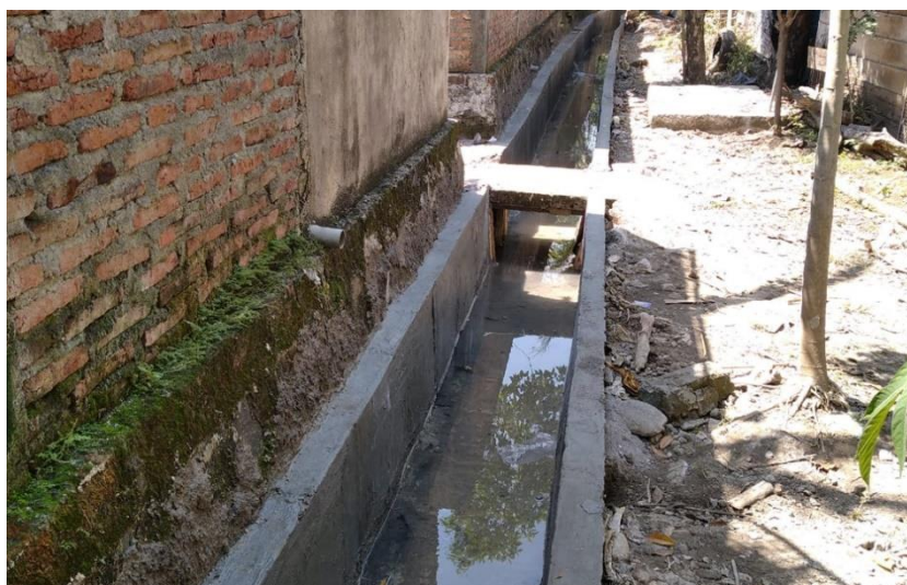
Gambar 7. Kondisi saluran drainase setelah pekerjaan
