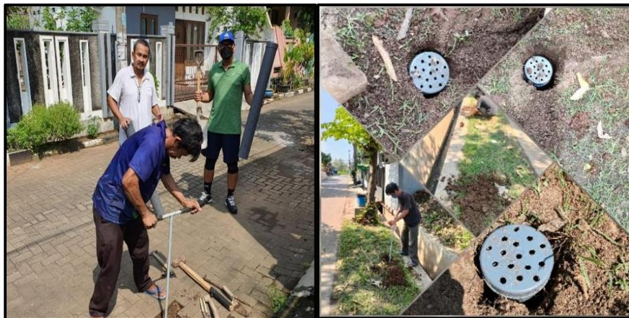
Gambar 1. Pembuatan Lubang dan hasil pemasangan Biopori
