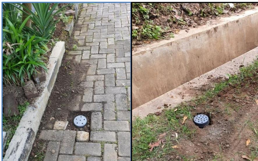
Gambar 2. Hasil pemasangan Biopori di Paving dan di Tanah
