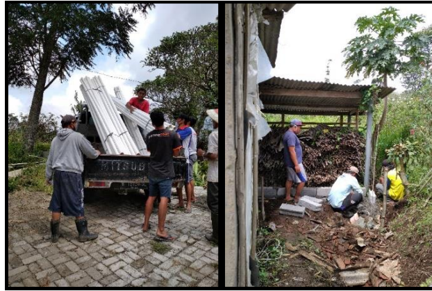
Gambar 6. Pembuatan instalasi perpipaan dan bak penampungan air dekat dengan lahan pertanian warga
