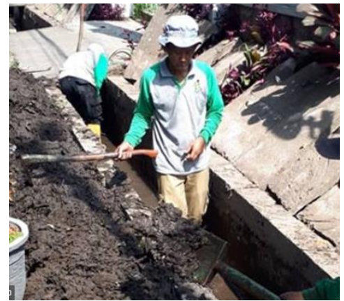
Gambar 3. 5 Contoh normalisasi saluran dengan tenaga manusia
