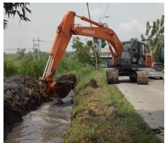
Gambar 3. 6 Contoh normalisasi saluran dengan alat berat
