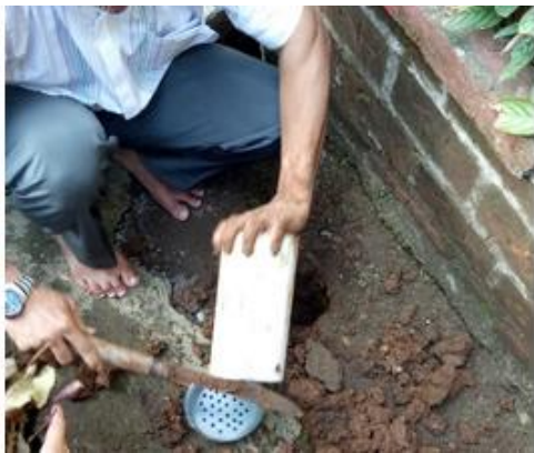
Gambar 4. Memasukkan Paralon ke dalam Lubang Biopori
