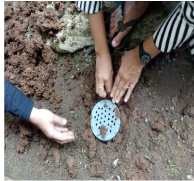
Gambar 6. Menutup Lubang Biopori dengan Paralon
