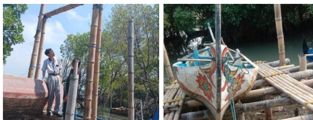
Gambar 3. Penyangga utama dok perahu
