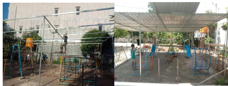
Gambar 2. Pembuatan rangka dan atap kanopi
