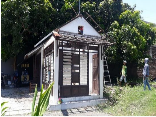
Gambar 1 Kondisi Eksisting Pos Kamling
