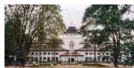
Tampilan bangunan yang simetris, simbolis bangunan pemerintahan
