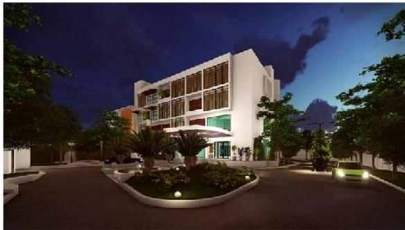
Gambar disamping merupakan perspektif dari bangunan, dari gambar tersebut terlihat bahwa pemakaian bahan bangunan adalah paduan antara concrete dengan kayu. Tujuan dari penggunaan material kayu adalah untuk sedikit meredam perpindahan panas kedalam bangunan.
