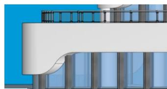
Dinding fasad berupa *curtain wall* serta memiliki rasio luas jendela dengan luas dinding (VWR) sebesar 40%. Selain itu, desain fasad memiliki *shading* horizontal dengan tinggi (Dh) 60 cm dan *shading* vertikal dengan tinggi (Dv) 50 cm.
