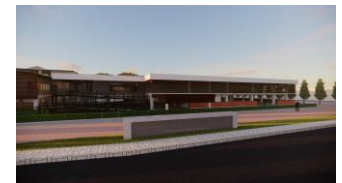
Penggunaan sunshading kayu pada fasad depan sekolah yang menghadap ke barat.
