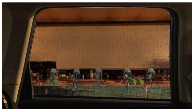
Secondary skin saat tertutup untuk mengurangi intensitas air hujan yang masuk kedalam bangunan.
