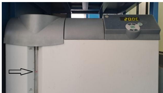
Gambar. 9 Indikator volume air pada unit cooling water
