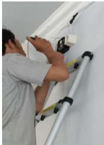
Gambar 2. Pemasangan rangkaian mikrokontroller pada perangkat AC
