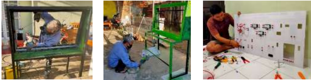
Gambar 2. Pengelasan rangka, pengecatan dan instalasi komponen elektrikal modul
