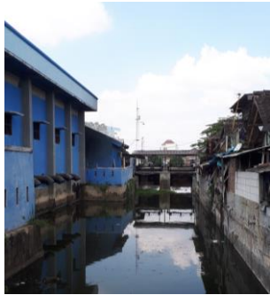
Gambar 9. Pintu air Kali Semarang Sumber: Observasi Lapangan, 2019
