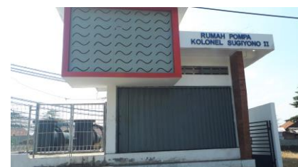
Gambar 8. Bangunan rumah pompa 2 Sumber: Observasi Lapangan, 2019
