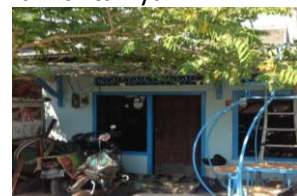
Gambar 2. Bangunan rumah tinggal warga yang ditinggikan lantainya Sumber: Observasi Lapangan, 2019
