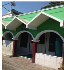
Gambar 4. Bangunan musholla Gang Banjar yang direnovasi
