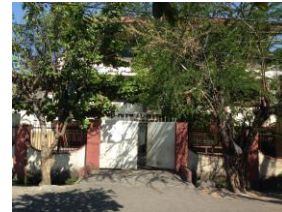
Gambar 5. Bangunan SD-SMP Al-Irsyad Al-Islamiyah yang direnovasi
