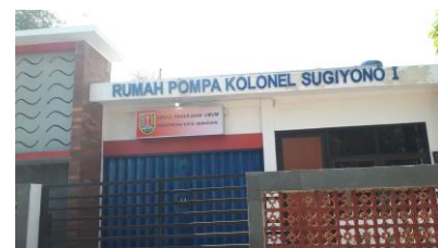
Gambar 7. Bangunan rumah pompa 1 Sumber: Observasi Lapangan, 2019
