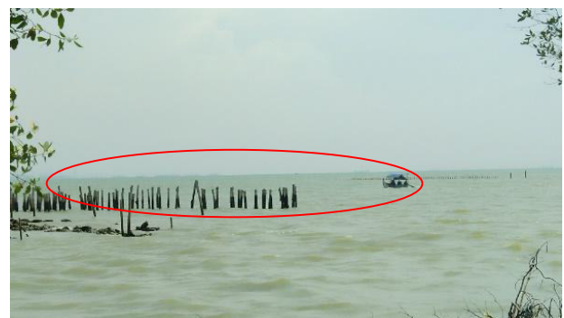
Gambar 5. Struktur Permeabel Bambu, Salah Satu Program Hybrid Engineering (HE) oleh Wetlands International Indonesia (WII)
