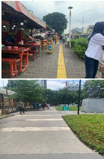
Gambar 6. Kondisi Jalur Pedestrian
