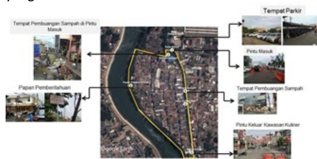
Gambar 2. Kondisi Infrastruktur di Kawasan Pasar Lama Tangerang
