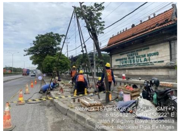
Gambar 6. Pekerjaan soil test
