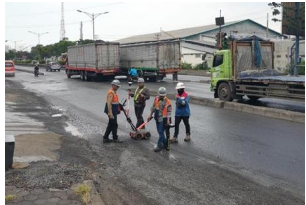
Gambar 5. Pekerjaan georadar survei
