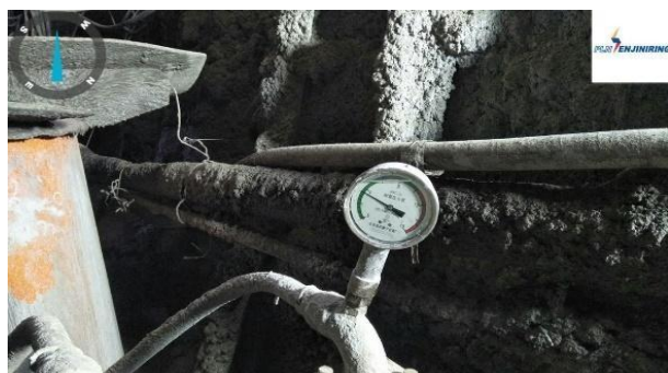
Gambar 20. Pemantauan tekanan grouting
