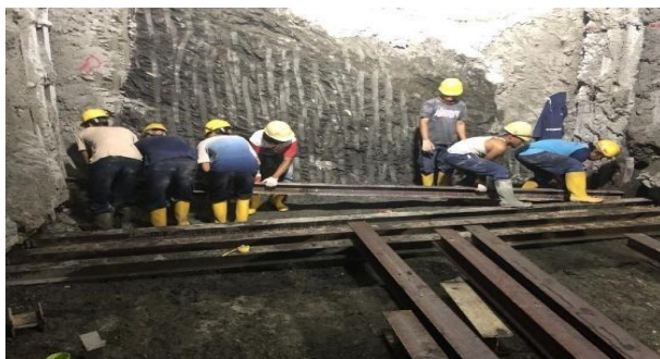
Gambar 13. Pelaksanaan drilling dengan alat TMZ1250 crawler drill
