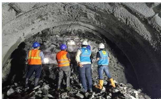
Gambar 5. Pengecekan bersama kondisi batuan di horizontal penstock tunnel face
