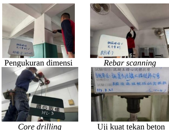
Gambar 5. Pengambilan data bangunan eksisting: (a) pengukuran dimensi, (b) core drilling, (c) rebar scanning, (d) uji kuat tekan
