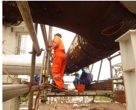
Gambar 5. Pembongkaran & pembersihan di lokasi titik kebocoran di 201-C-001
