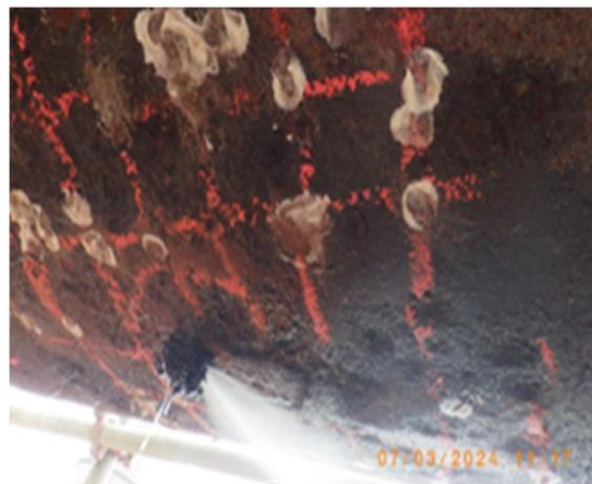
Gambar 2. Kondisi pipa setelah dibuka isolasi
