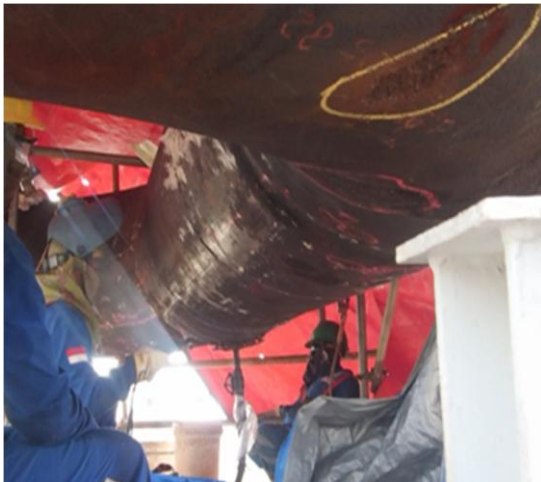
Gambar 17. Pembersihan sekitar area titik kebocoran
