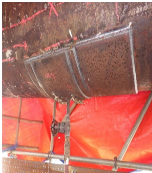
Gambar 19. Hasil pengelasan tampak samping
