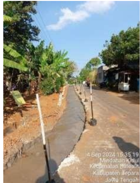
Gambar 3. Pekerjaan lantai dasar F'c 10 Mpa
