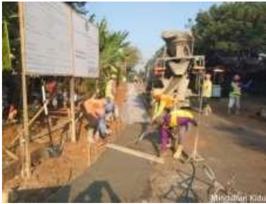
Gambar 5. Pengecoran beton mutu F'c 25 Mpa
