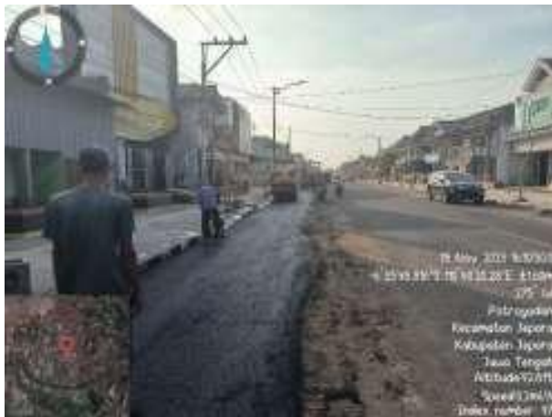
Gambar 12. Pekerjaan laston lapis antara (AC- BC)
