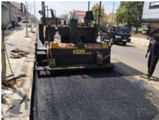
Gambar 13. Pekerjaan laston lapis aus (AC-WC)
