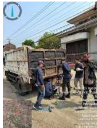
Gambar 11. Pengujian CBR lapangan
