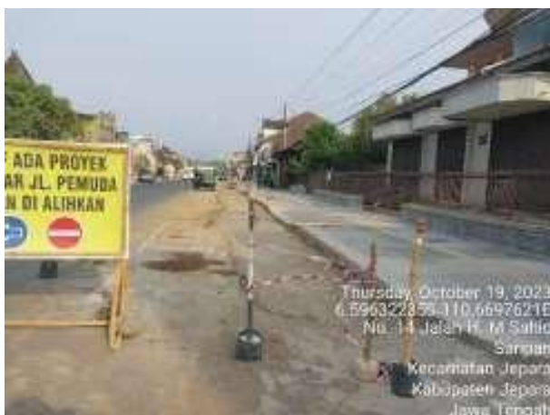
Gambar 9. Pekerjaan LPA kelas A
