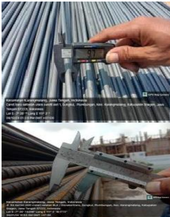
Gambar 11. Besi tulangan tiba di proyek dilakukan pengecekan baik jumlah maupun diameternya dengan sketsmatch digital dan sketsmatch manual
