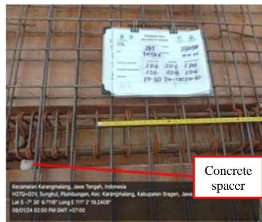
Gambar 6. Setelah perbaikan, jarak begel disesuaikan desain rencana
