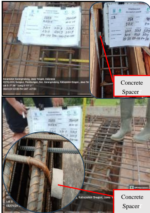
Gambar 4. Setelah perbaikan balok 26KB (b : lebar) dan (h : tinggi) dan penambahan concrete spacer (tahu-tahu)
