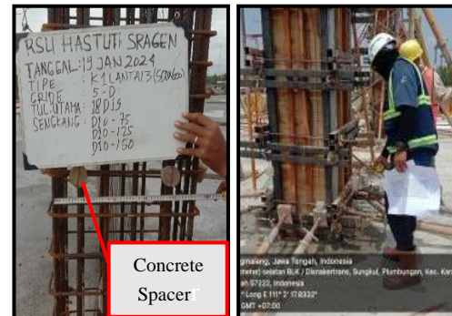
Gambar 3. Penambahan concrete spacer (tahu-tahu), perbaikan lot/vertikal line pada bekisting kolom
