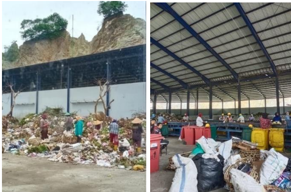
Gambar 4. Kondisi Unit Picking Bay tanpa atap dan kondisi pemilahan sampah di conveyor belt (Sumber: TPA Kebon Kongok, 2024)
