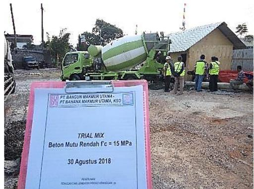
**Gambar 9.** Kegiatan *trial mix* campuran beton di *batching plant* penyedia jasa, Kab Temanggung
