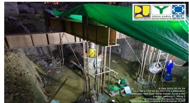
Gambar 13. Test beban axial tekan
